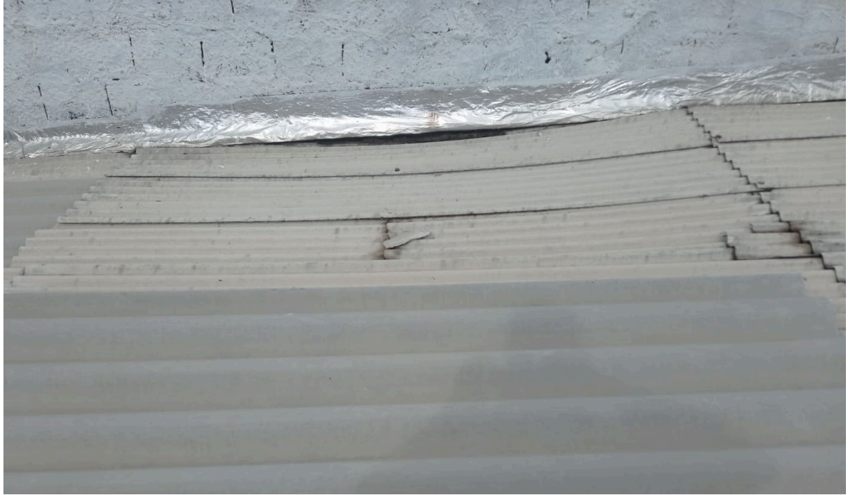
Imagem 4: Telha trincada
