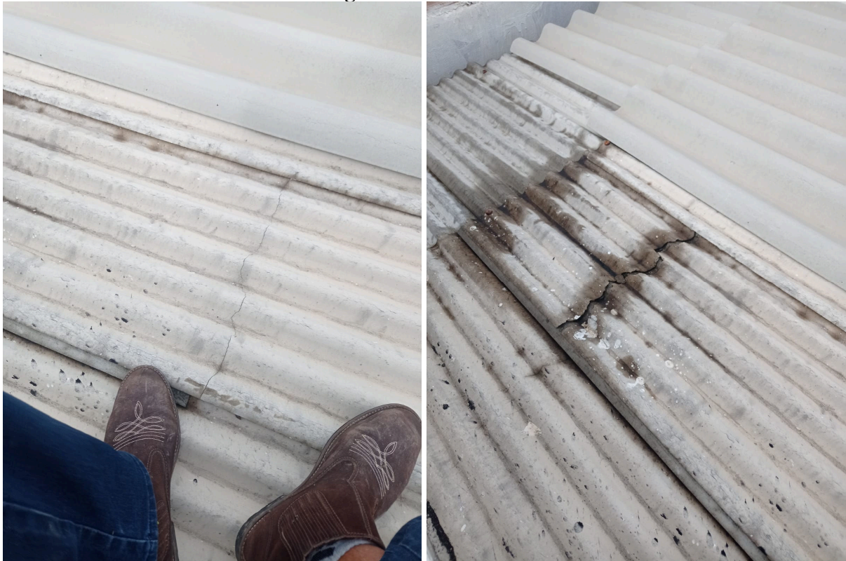
Imagem 3: Telha trincada
